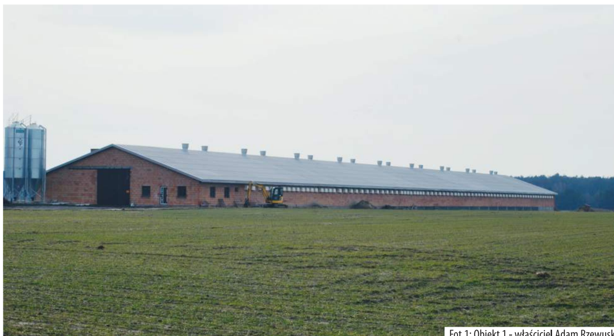
Fot.1: Obiekt 1 - właściciel Adam Rzewuski
