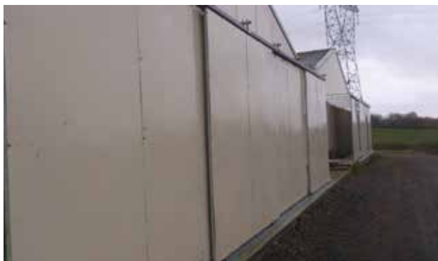
zdj 3. Szczytowa ściana budynku z przesłonami wlotu powietrza.
