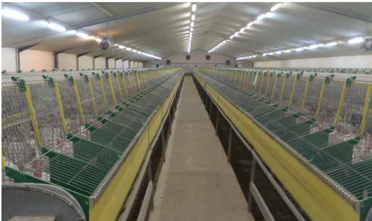
zdj 5. Hala reprodukcyjna, na przeciwległej ścianie szczytowej widoczne wyciągi powietrza umożliwiające kontrolę warunków mikroklimatycznych obiektu.
